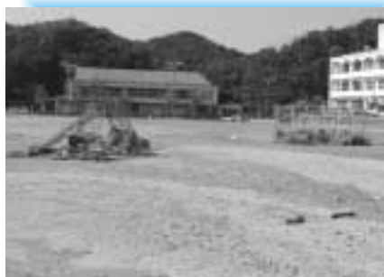
大量の土砂が流れ込んだ鮎原小グラウンド
