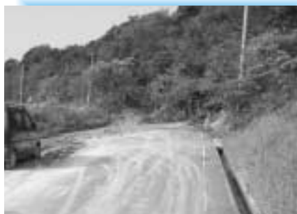
県道多賀洲本線 鮎原上～塔下付近
