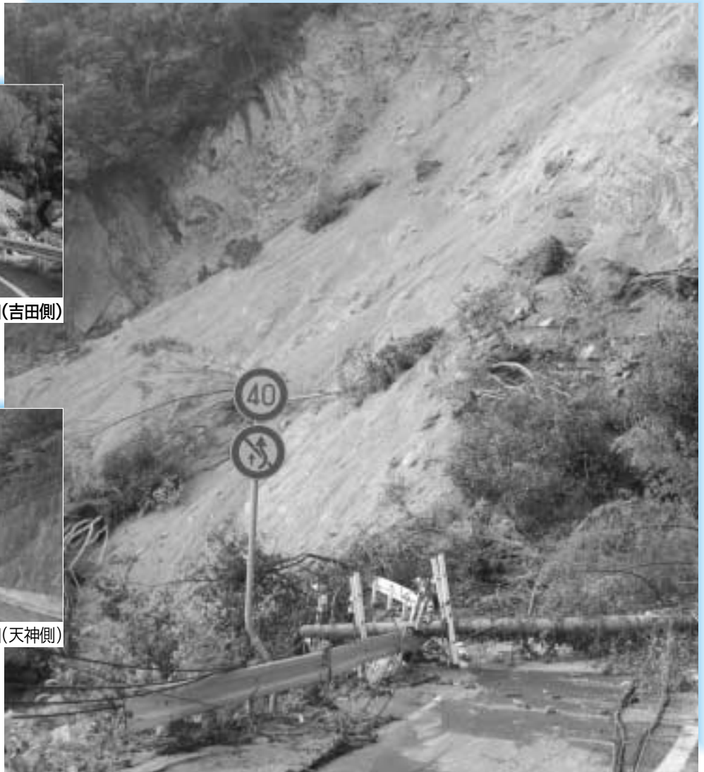
県道洲本五色線 鮎原天神～吉田間で大規模な土砂崩れがあり、今後の復旧には日時を要します。
