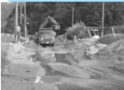
塔下川・枇杷の奥川の氾濫で土砂が県道を塞ぐ
