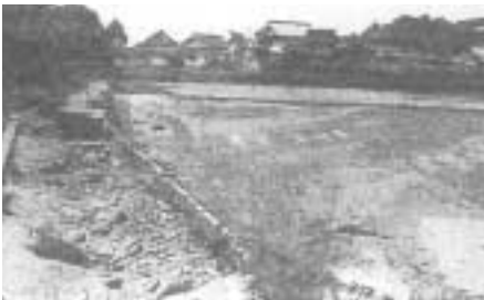
▲都志川氾濫による被害 (都志大宮付近) (S49.7.7 台風8号)
