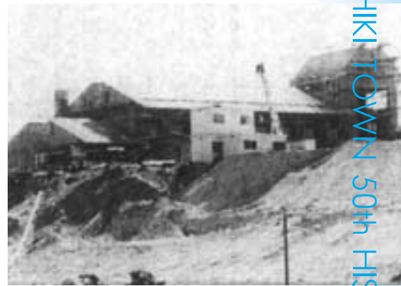
▲工事中の健康村（S56.10）
