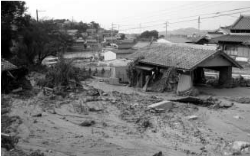
▲台風23号で町内に大きな爪跡 (写真一三野畑地区)
