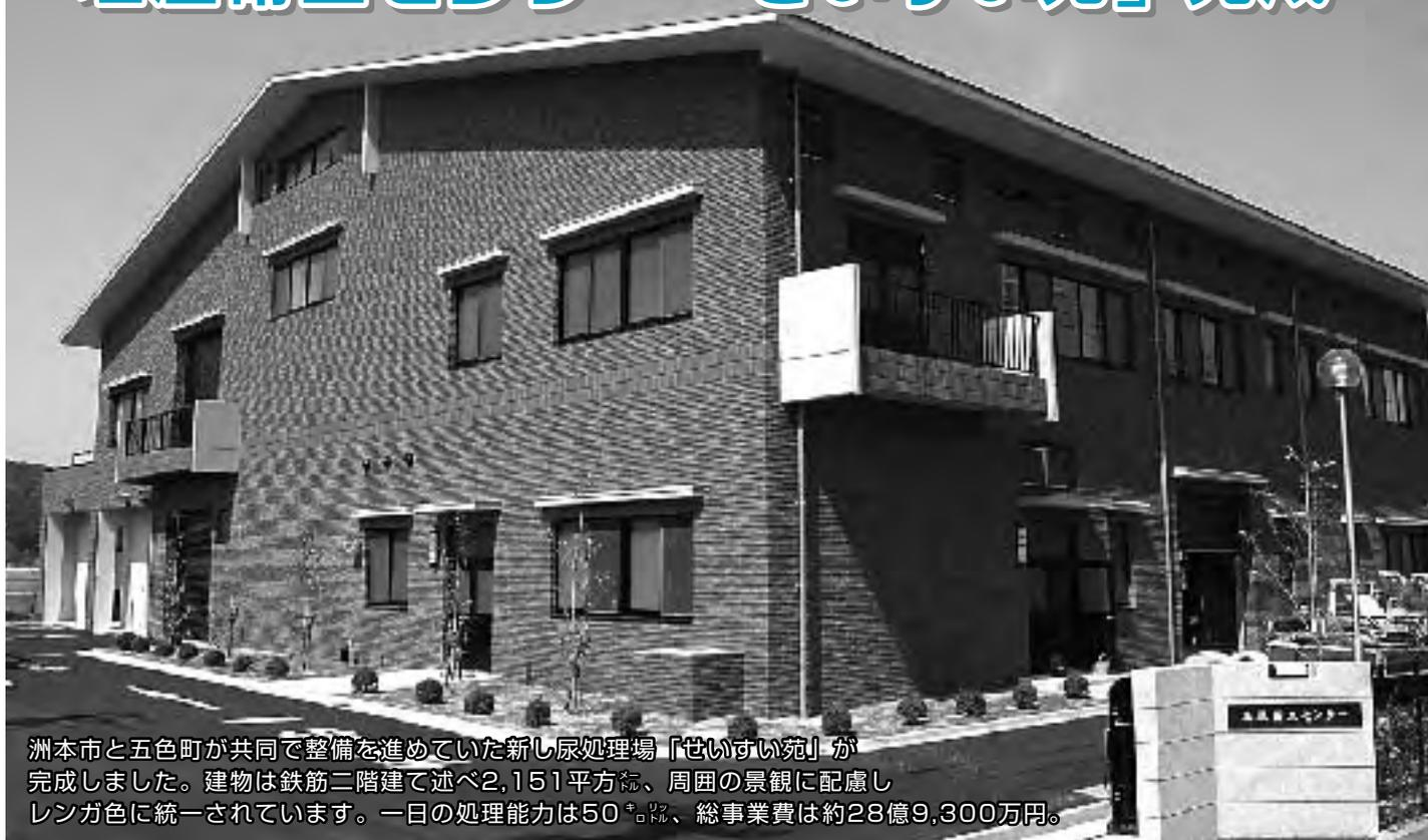
洲本市と五色町が共同で整備を進めていた新し尿処理場「せいすい苑」が完成しました。建物は鉄筋二階建てで述べ2,151平方メートル、周囲の景観に配慮しレンガ色に統一されています。一日の処理能力は50<sup>立方メートル</sup>、総事業費は約28億9,300万円。
