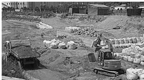
河川に流れ込んだ土砂の撤去作業は急ピッチで行われました。
