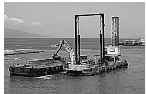
洲本川河口部では浚渫工事が本格化しています。
