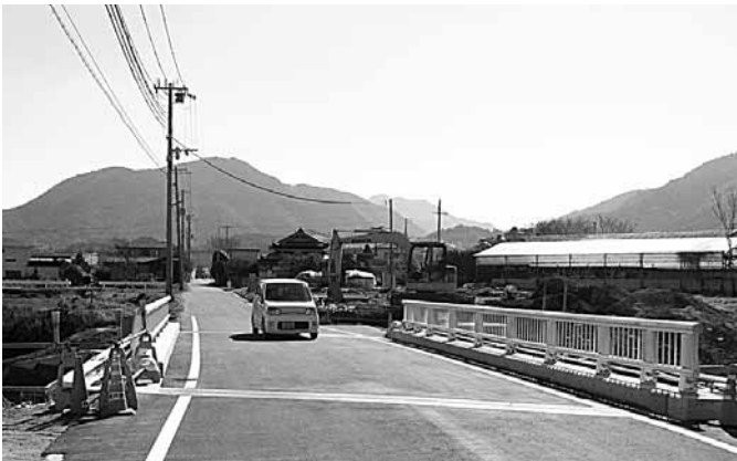
開通した白谷橋
