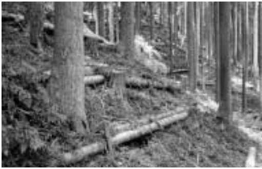
▲間伐木を利用した土留工の設置
