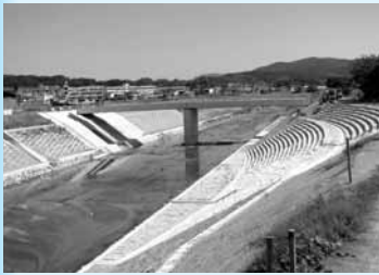
▲加茂地区 護岸改修状況
