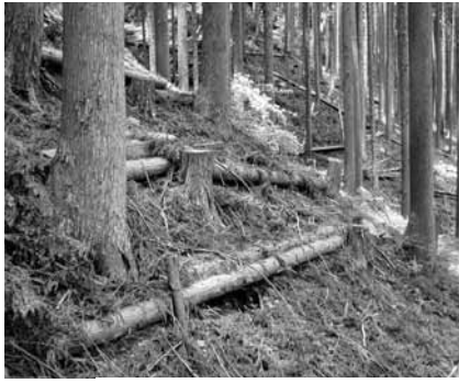
▲間伐木を利用した土留工の設置
