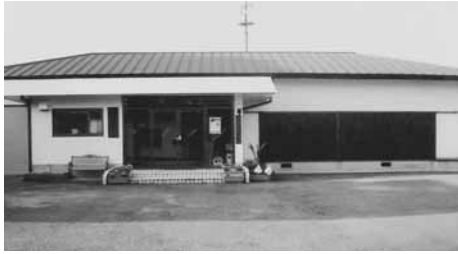
▲平成20年度事業を活用して改修を終えた安坂上集会所
