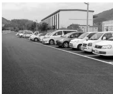
▲4月1日、仮オープンする洲本インターチェンジ駐車場
