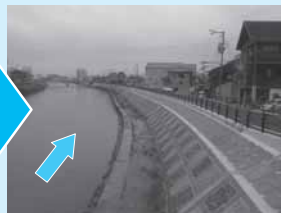
改修後(不二美橋下流)
