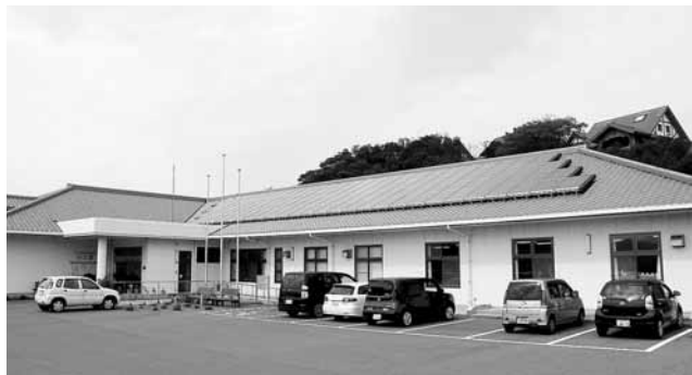
夢工房屋根に取り付けられた太陽光発電パネル
