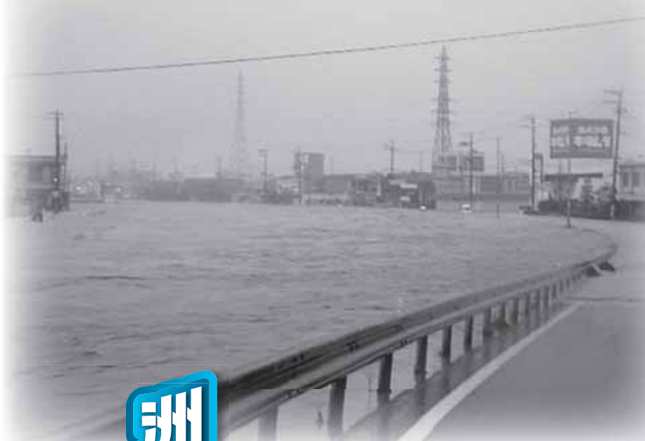
▲洲本川出水状況
