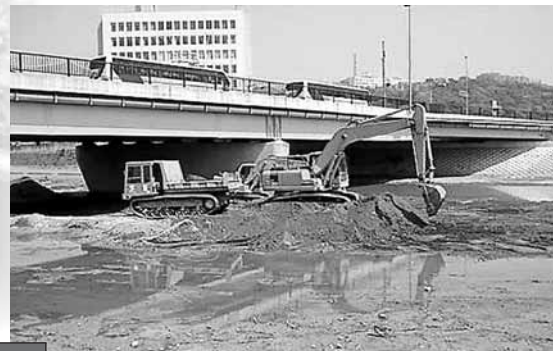
▲洲本川堆積土砂撤去
