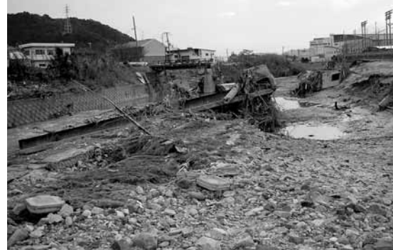
▲護岸崩壊、流出した橋
