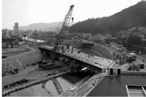
▼新加茂橋建設中
