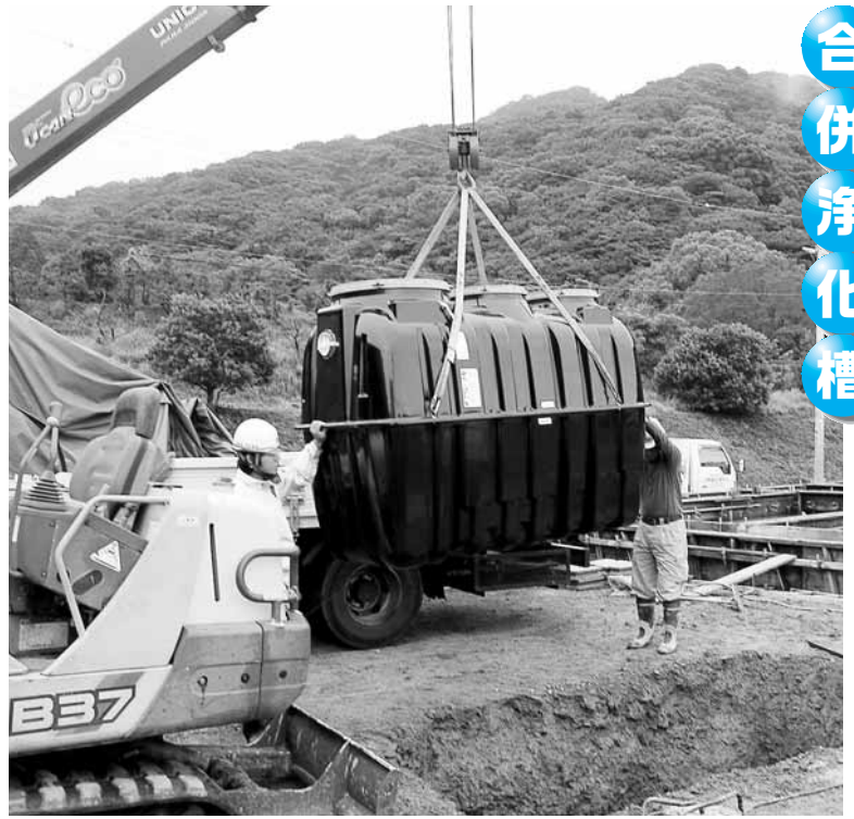
設置中の合併浄化槽
