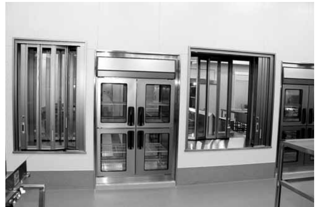
▲検収室(奥側)できれいにした食材を調理室(手前側)へ
