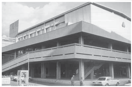
竣工当初の市民会館
