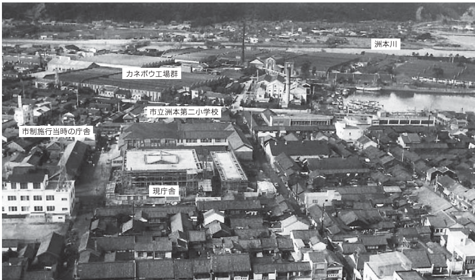
※写真にある市立洲本第二小学校の跡地に、昭和40年から市民会館が、現在は新庁舎が建っています。
