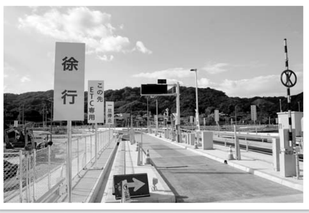
工事中のスマートIC入口の様子(11月末時点)
