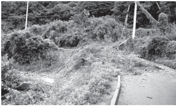
市道根来線の土砂崩れの様子
