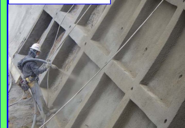
吹付モルタル工(第3法面)
