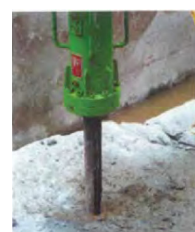
ドリルで岩盤に穴を開けます
