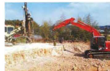
ドリルで岩盤に穴を開けます
