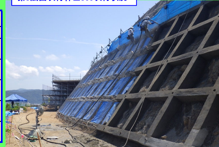
第3法面吹付枠口300吹付状況
