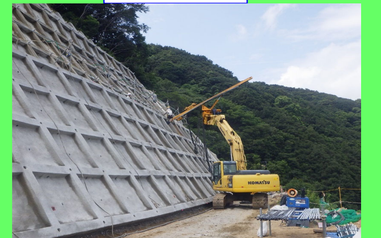
鉄筋挿入施工状況
