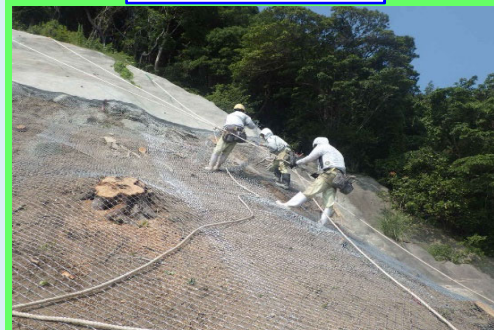
アンカー施工状況
