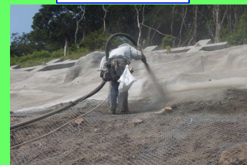
モルタル吹付状況
