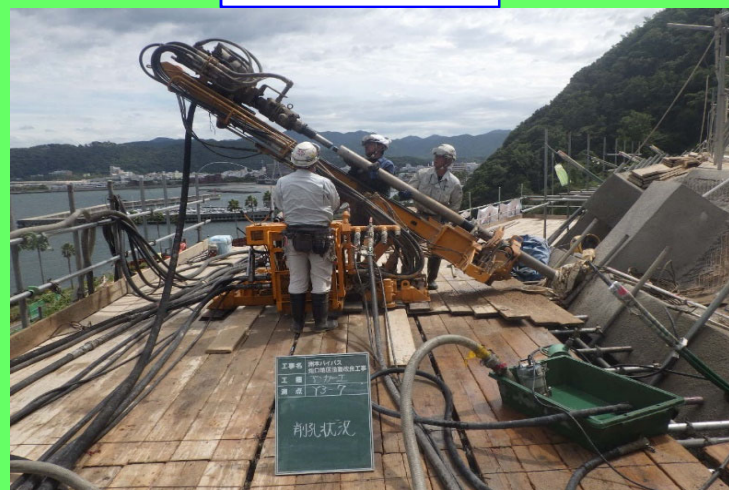
アンカー施工状況
