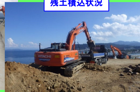
残土積込状況
