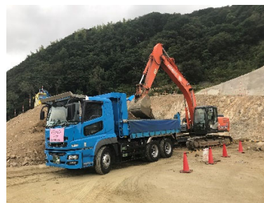
残土積込状況
