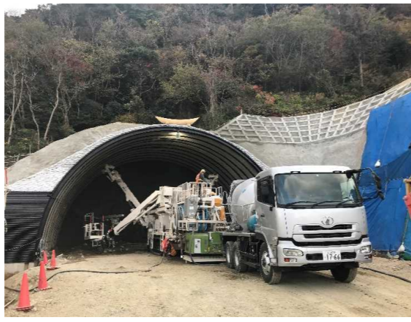
トンネル掘削工 吹付コンクリート施工状況
