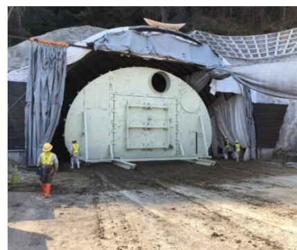
仮設備工（防音、飛石対策） 防音扉設置状況
