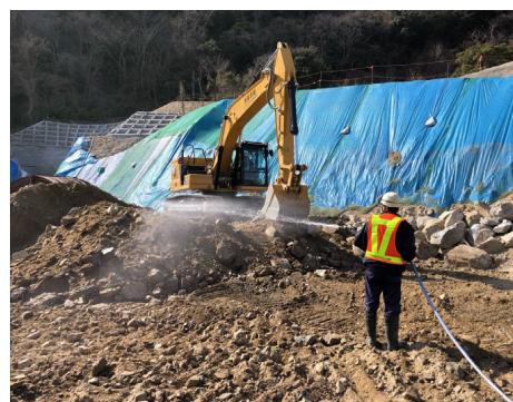
残土処理工（防塵、飛散対策） 散水状況
