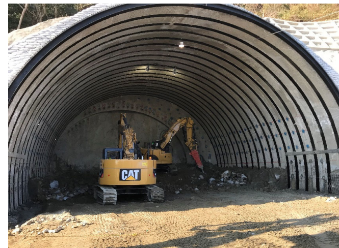
トンネル掘削（機械掘削） 状況
