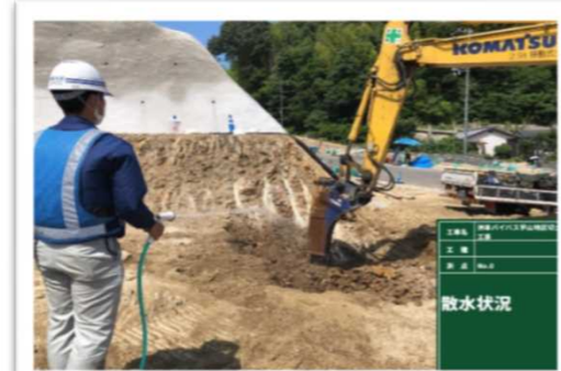
岩掘削作業時に散水実施
