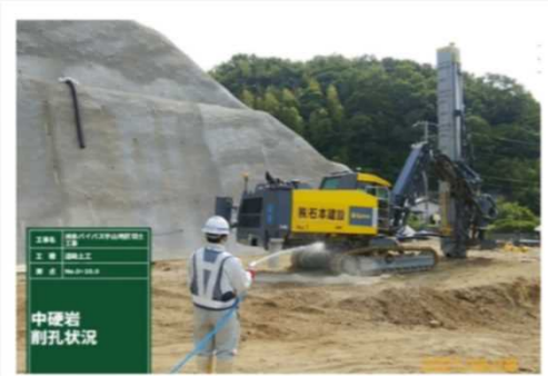
岩掘削作業時に散水実施
