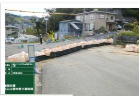
大型土のうによる締切実施
