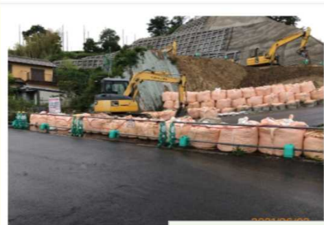
大型土のうによる締切実施
