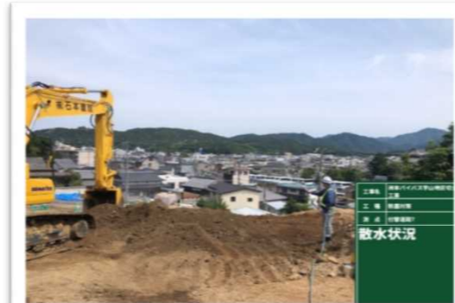
掘削作業時に散水実施
