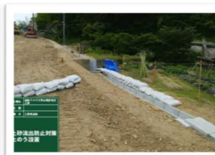
土のうによる土砂流出防止
