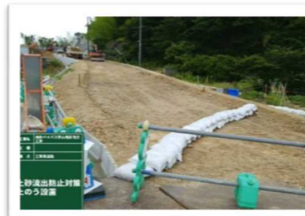
土のうによる土砂流出防止
