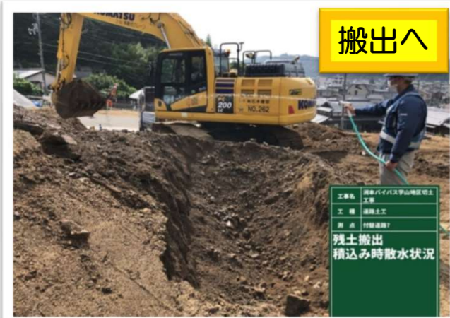
土砂積込時に散水実施
