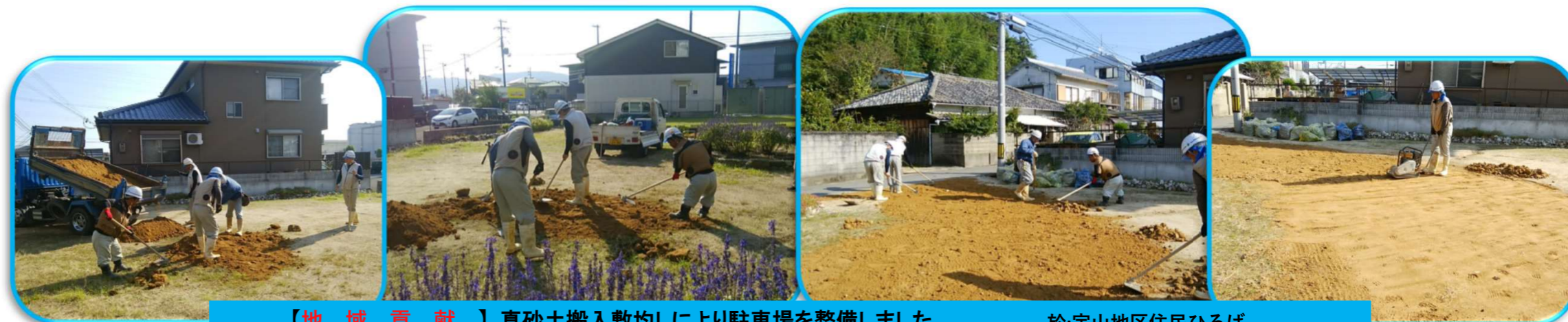
【地域貢献】真砂土搬入敷均しにより駐車場を整備しました。
