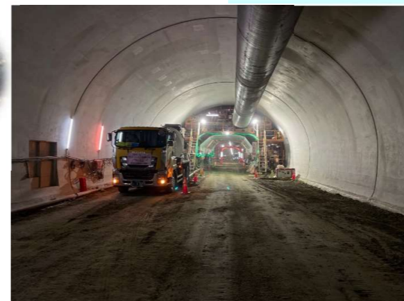
トンネル坑内 覆工打設状況
