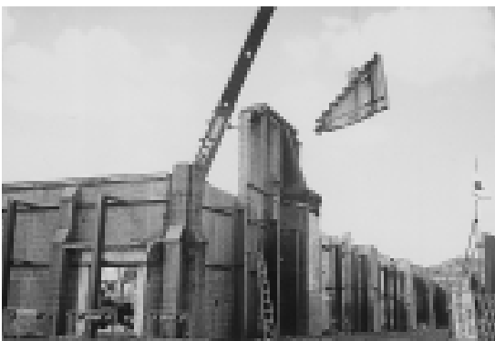
工事中の図書館
