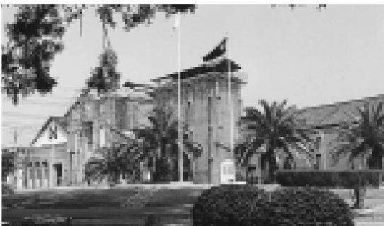
解体前の工場
