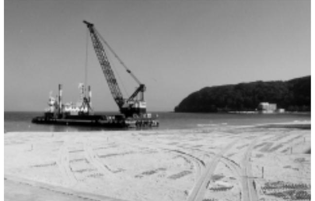
淡路県民局県土整備部洲本土木事務所により、大浜海岸の北側で養浜工事が行われており、3月末に完了する予定です。今回は1万6000立方メートルの砂が投入され、新たに約4000平方メートルの砂浜が4月からは利用できるようになります。夏には美しい海岸で海水浴が楽しめます。
