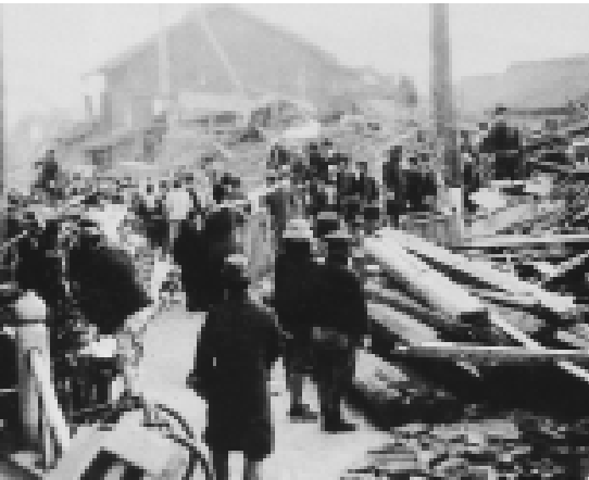
南海地震で多くの家が倒壊した物部1丁目
