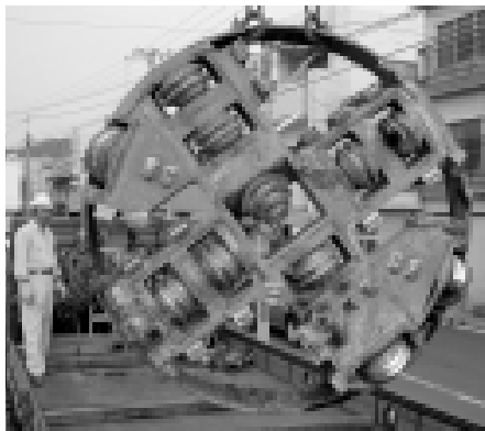
シールドマシン解体状況
