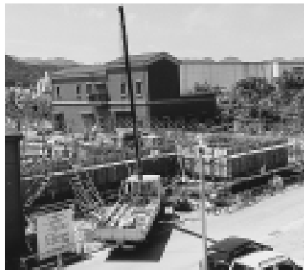
工事中の最初沈殿池
