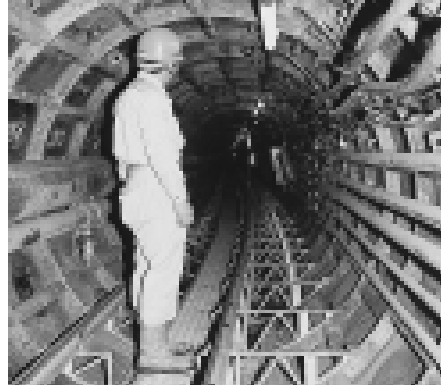
汚水管中間地点 シールドトンネルの直径は約2.6m。この後、坑内の清掃、レールなどの撤去工事を行い、内径約1.8mの汚水管に仕上げます。
