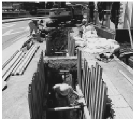
下水道工事現場
