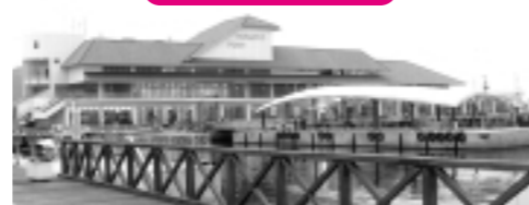
CATV基地整備
