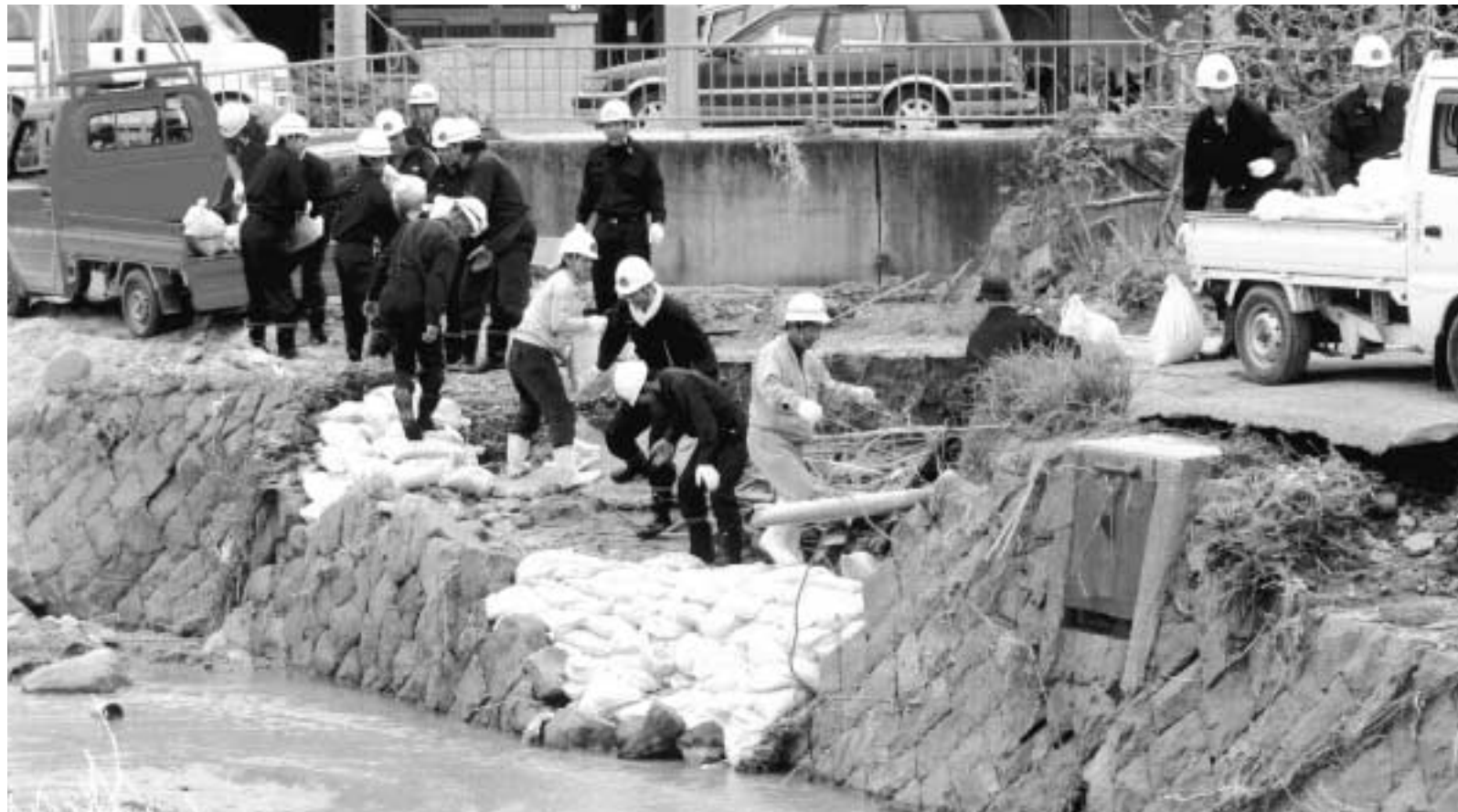
2次災害防止のため必死に土のうを積み上げる消防団の皆さん(10月29日)
