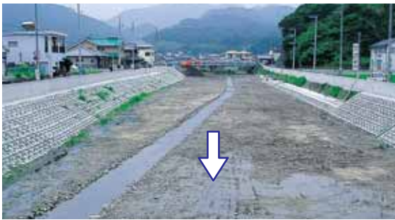
▼現地の石を用いた緩傾斜式落差工(猪鼻川)
