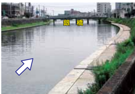
完了した矢板護岸(物部地区)
