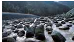
▼現地の石を用いた緩傾斜式落差工(猪鼻川)
