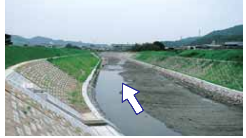
▼完成した新しい護岸(加茂地区)
