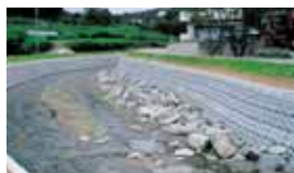
魚道もあわせて整備された緩傾斜式の落差
