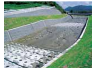
▲生き物の遡上に配慮した緩傾斜式の落差工(鮎屋川)
