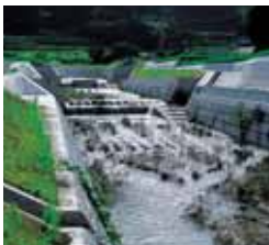
魚道もあわせて整備された緩傾斜式の落差
