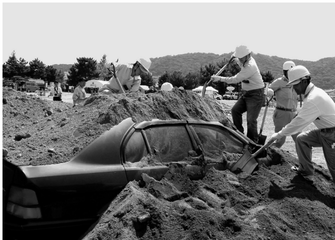
▲車にかぶさった土砂を取り除く訓練参加者＝メイン会場
