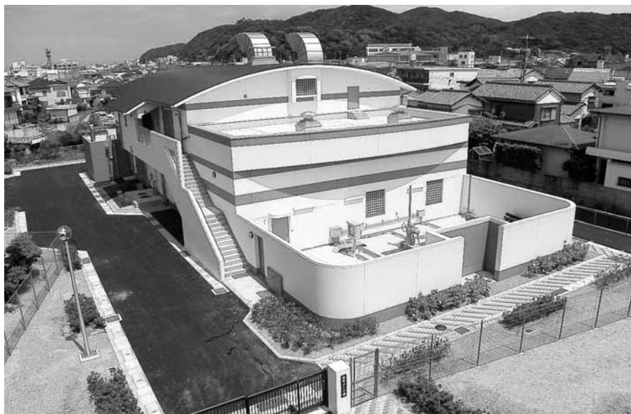
物部ポンプ場全景
