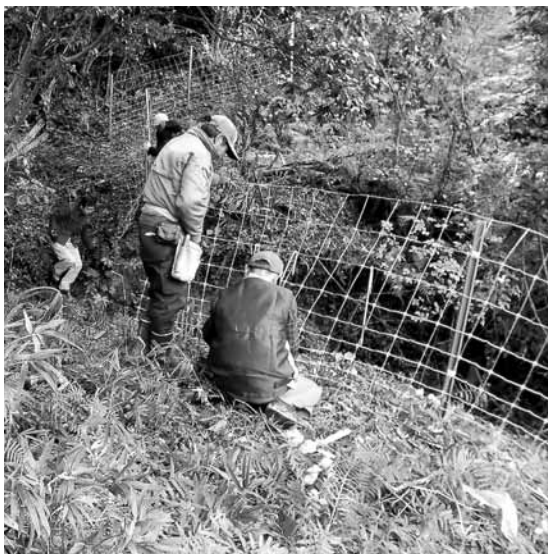
侵入防止柵の設置
