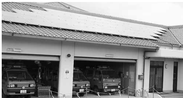
▲防災センター鳥飼会館の太陽光発電設備
