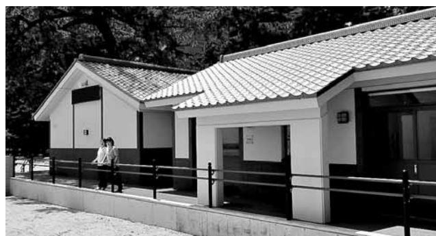
▲大浜公園に完成したメインビーチハウス
