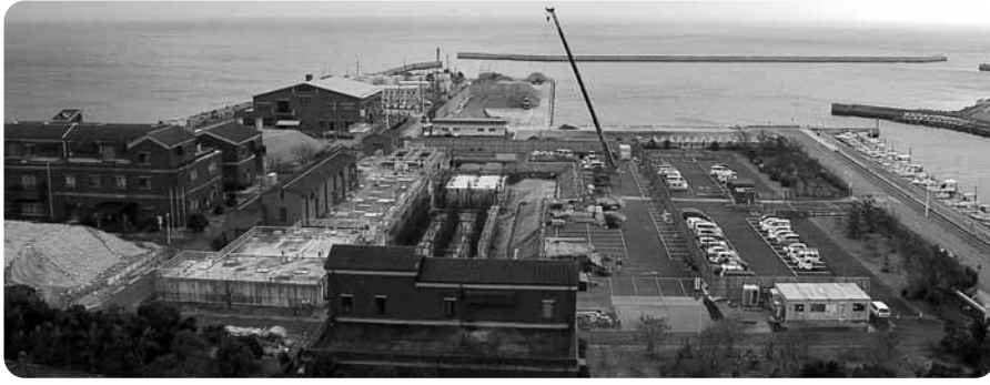
拡張工事が進む下水処理場
