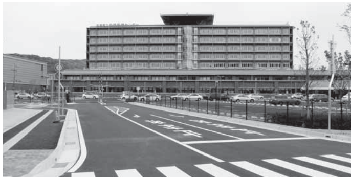
4月22日(月)に開通した市道塩屋2号線から撮影
