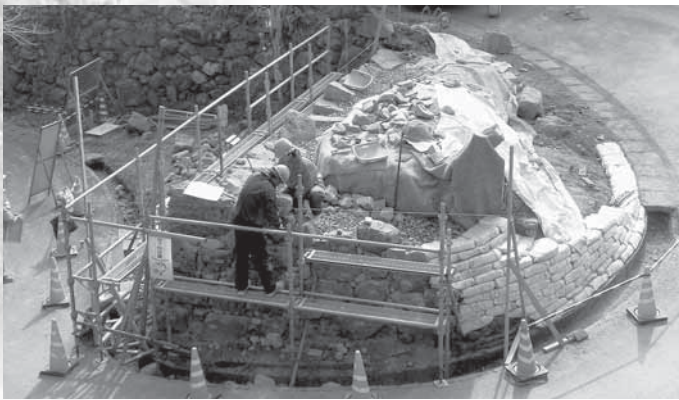
修復中の石垣（馬屋）
