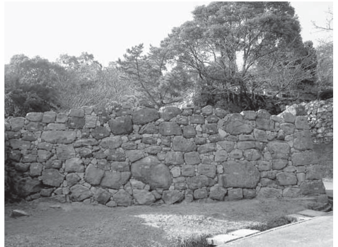
石垣修復後（馬屋）
