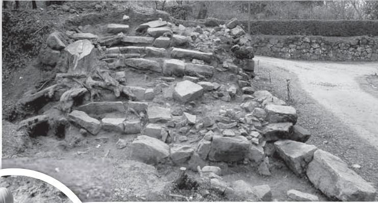
石垣修復中に発掘された石段（南の丸）
