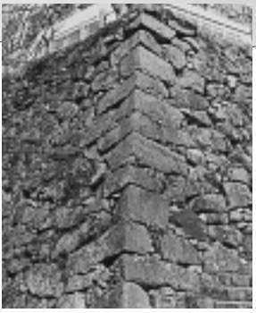
天守台南西の角石 大きな石材を交互に積み、算木積みの完成に近い。
