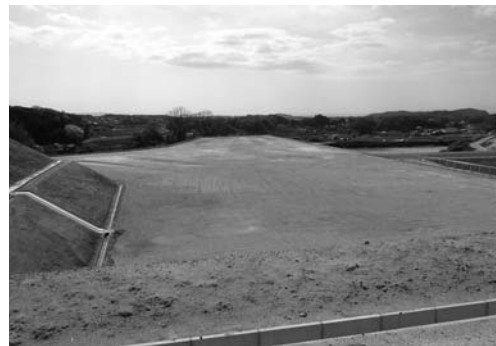
田中飼料株式の飼料工場が建設される予定の土地（五色町鮎原）
