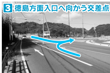
下り線出入口アクセス道路へ
